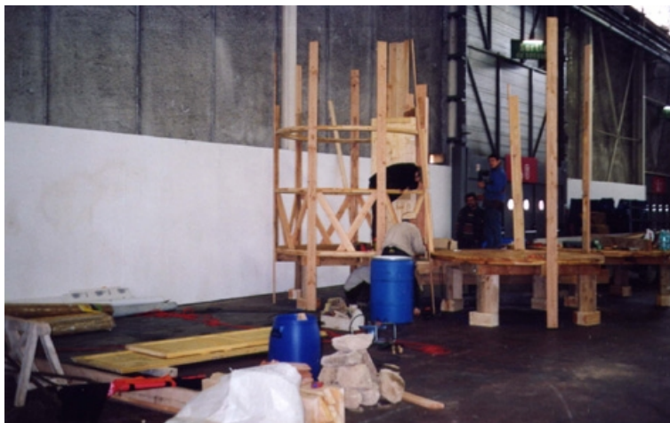
Photo 2 : Structure en Douglas non traité, parquet en pin des landes, bidons de récolte en plastique
