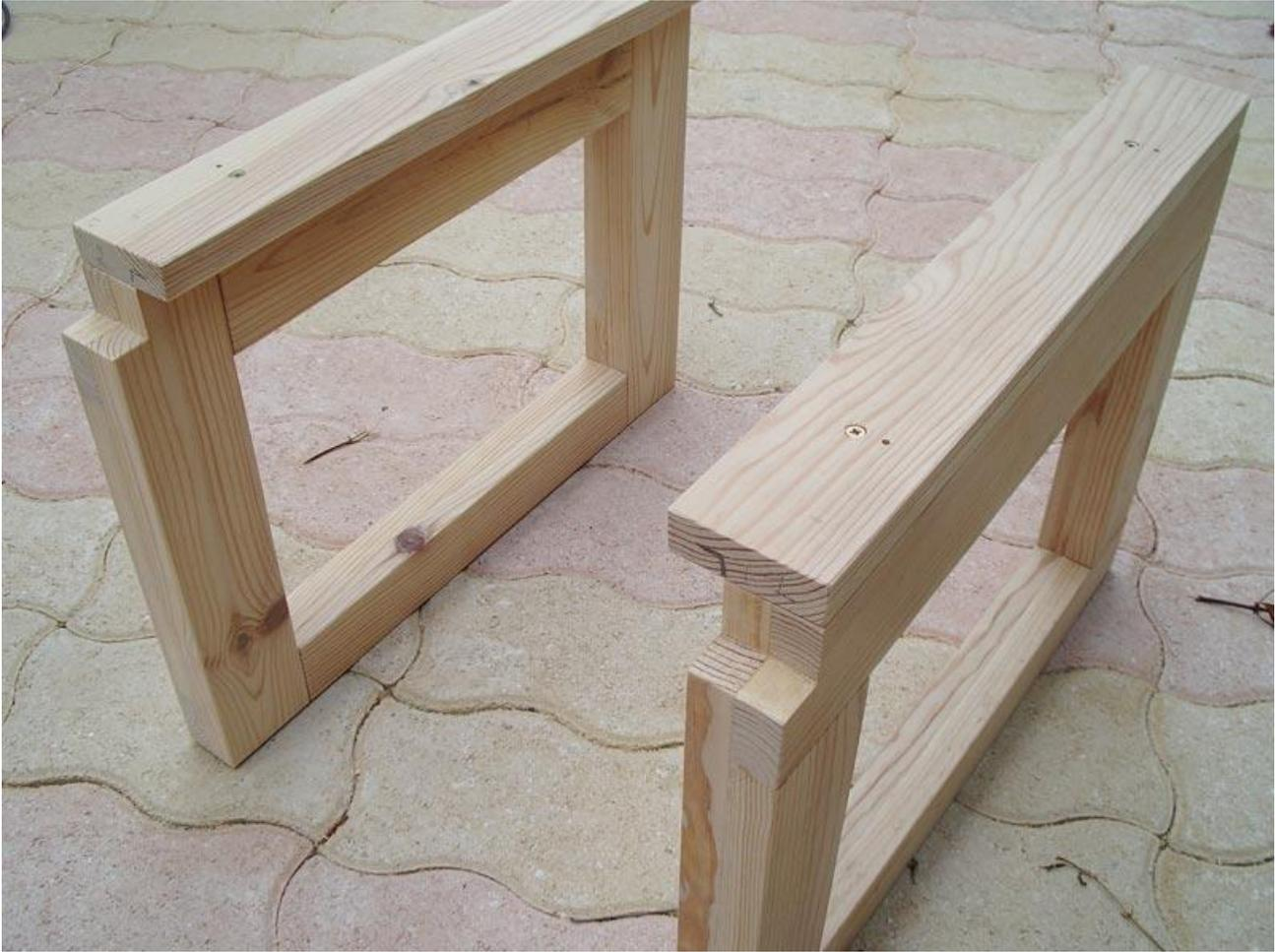
Dans l'optique de cette fiche, j'ai réalisé ces pieds (en lame de parquet) sous la forme de cadres collés grâce à un ersatz d'assemblage facilement réalisable pour les auto-constructeurs.
